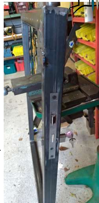
Mise en place serrurerie Avril 2021
