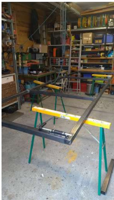
Découpes et soudures à l'atelier
